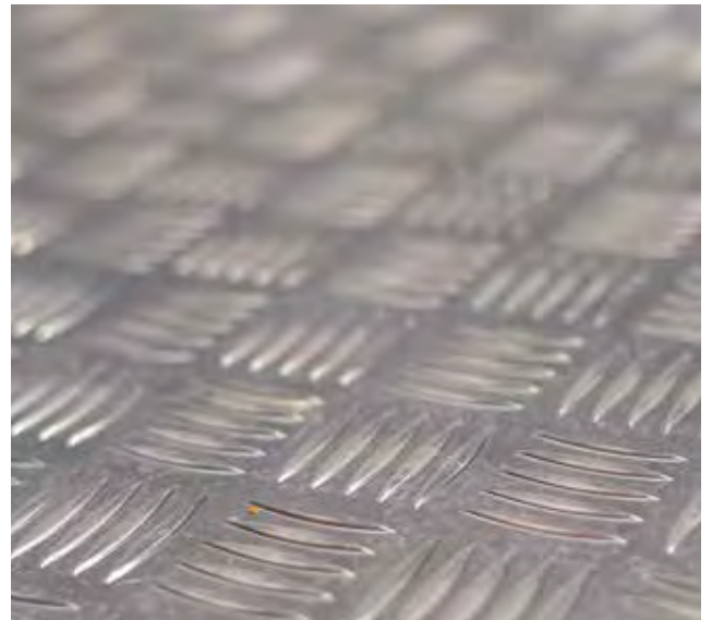
Boden mit Alu-Riffelblech belegt
